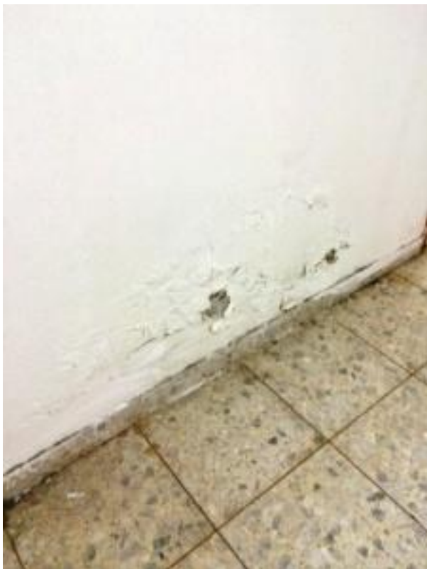
אטימה לקויה בין האמבט בחדר רחצה הורים לקיר. מים שחודרים במרווחים שבין חיבור האמבט לבין הקרמיקה, יוצרים רטיבויות בקירות.
