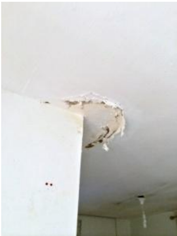
אטימה לקויה בין האמבט בחדר רחצה הורים לקיר. מים שחודרים במרווחים שבין חיבור האמבט לבין הקרמיקה, יוצרים רטיבויות בקירות.
