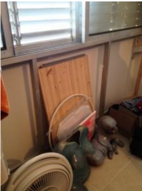
3. טרם בוצעה השלמת עבודות הגבס בחדר שינה הורים. נדרש להשלים פלטות גבס. (1,500 ₪)
