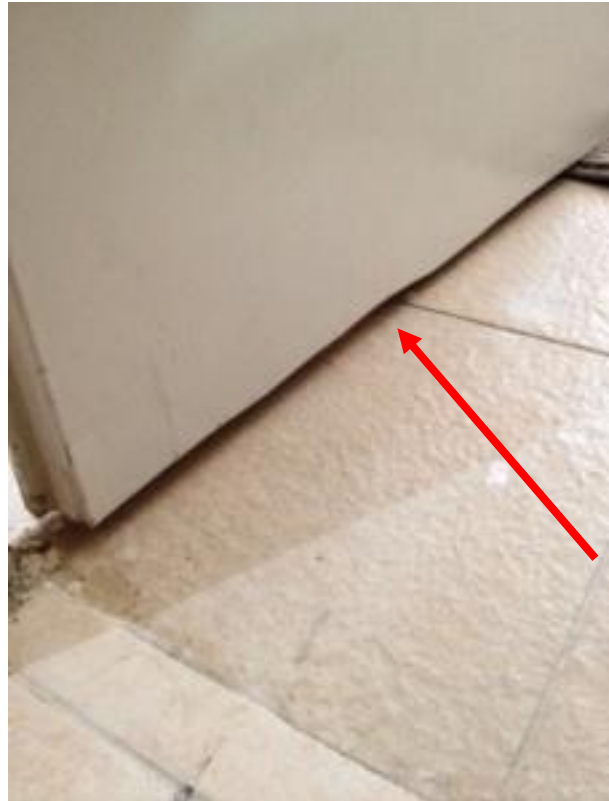
3. טרם בוצעה השלמת עבודות הגבס בחדר שינה הורים. נדרש להשלים פלטות גבס. (1,500 ₪)
