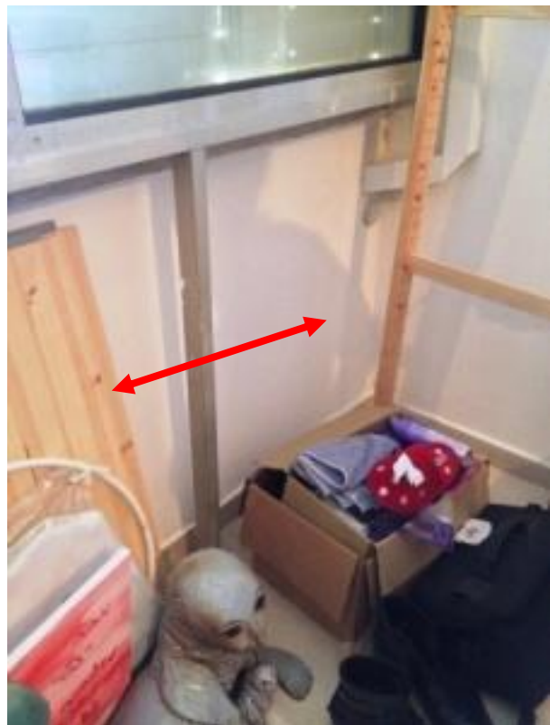
3. טרם בוצעה השלמת עבודות הגבס בחדר שינה הורים. נדרש להשלים פלטות גבס. (1,500 ₪)
