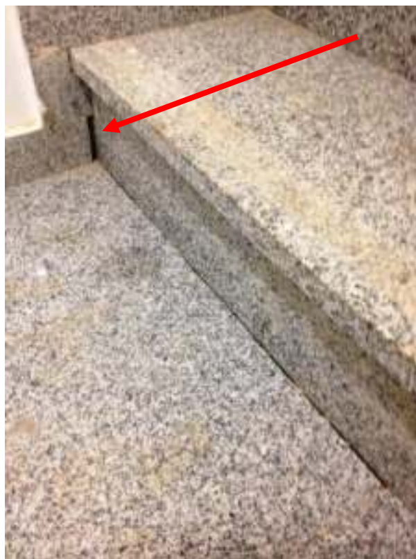
יש לאטום מרווחים בחיבורי המדרגות וכן לבצע החלפת ריצוף פגום. עלות מוערכת בכ - (600 ₪)
