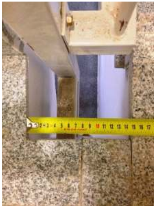
יש לאטום מרווחים בחיבורי המדרגות וכן לבצע החלפת ריצוף פגום. עלות מוערכת בכ - (600 ₪)
