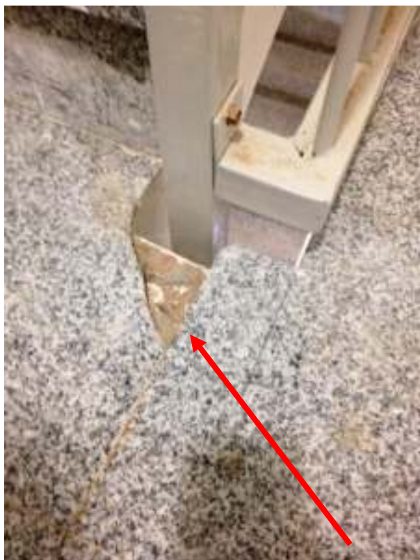
יש לאטום מרווחים בחיבורי המדרגות וכן לבצע החלפת ריצוף פגום. עלות מוערכת בכ - (600 ₪)
