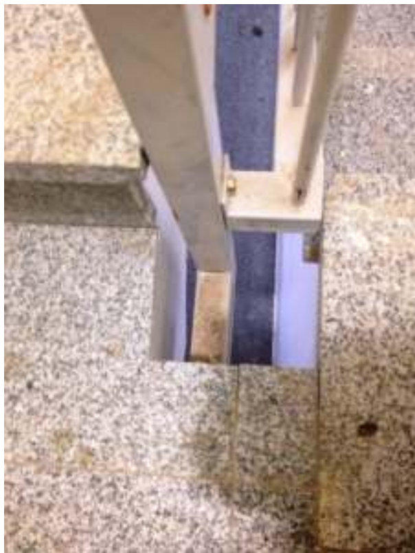
יש לאטום מרווחים בחיבורי המדרגות וכן לבצע החלפת ריצוף פגום. עלות מוערכת בכ - (600 ₪)
